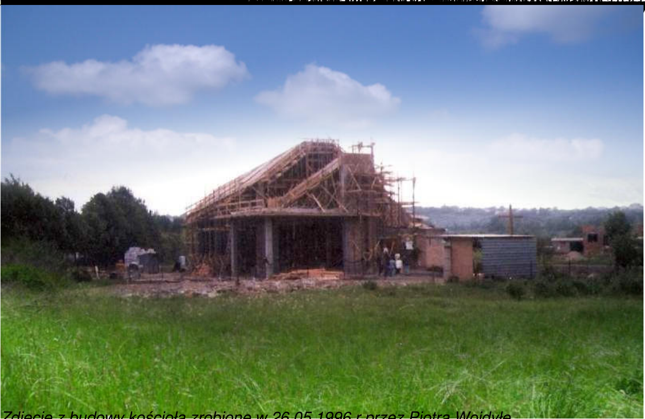
Zdjęcie z budowy kościoła zrobione w 26.05.1996 r przez Piotra Wojdyłę
